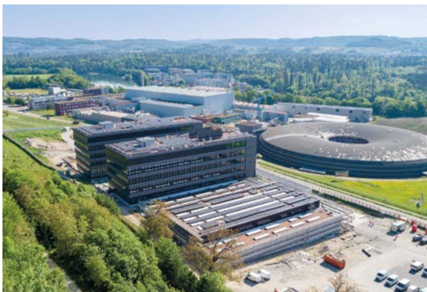
Naturwissenschaftlicher Campus: Die neuen Gebäude des Park Innovaare, daneben die runde Synchrotron Lichtquelle Schweiz des PSI (Bild: M. Teller)
