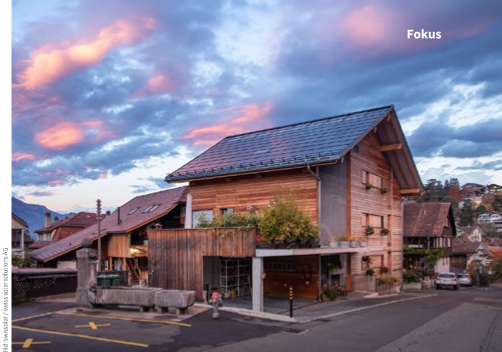
Bild: swissolar / swiss solar solutions AG Das Segment der Kleinanlagen unter 30 kW verliert an Dynamik. Die Anzahl Neuinstallationen ging 2024 erstmals um rund 5 Prozent zurück.
