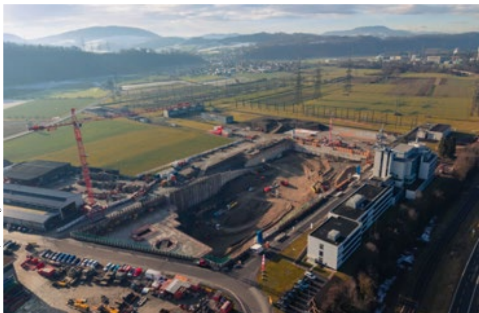
A Laufenburg (AG) sta sorgendo Flex-Base , il più grande impianto di accumulo a batteria con una potenza di 1200 MW e una capacità di 2100 MWh, progettato con tecnologia redox-flow. Il completamento è previsto per il 2028. L'immagine mostra l'enorme cantiere e la «Stella di Laufenburg» nel gennaio 2026.
