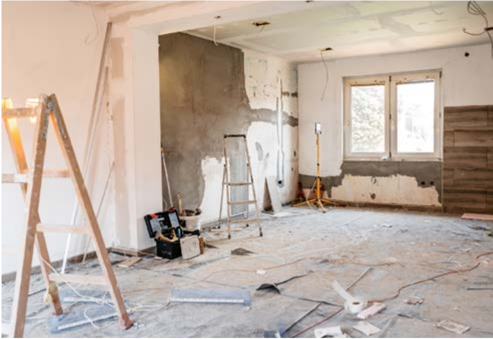
Un potentiel considérable: ces cinq dernières années, plus de CHF 2,4 mia ont été investis en moyenne chaque année dans la rénovation de maisons individuelles et environ CHF 5,2 mia dans l'assainissement d'immeubles collectifs.
