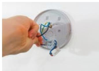
Schritt 1: Montageplatte montieren und anschliessen (bei der asymmetrischen ALPHA I-A, für Korridore/Fluchtwege, auf die Ausrichtung achten!)
