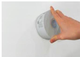
Schritt 2: Leuchte mit Montageplatte verbinden und einklicken
