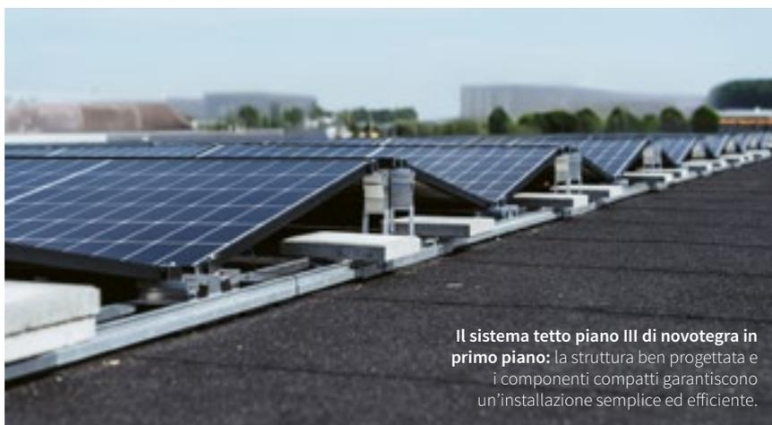
Il sistema tetto piano III di novotegra in primo piano: la struttura ben progettata e i componenti compatti garantiscono un'installazione semplice ed efficiente.
