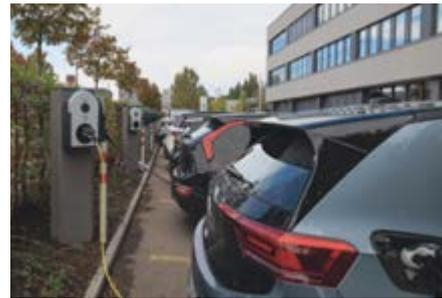
Il sistema di gestione del carico controlla oltre 30 stazioni di ricarica CA e CC di diversi produttori.
